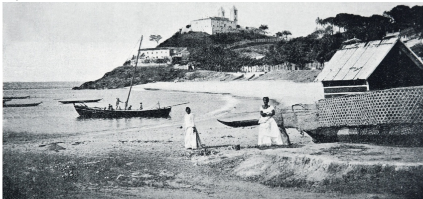
Figura 3 – Porto da Barra, c. 1903
